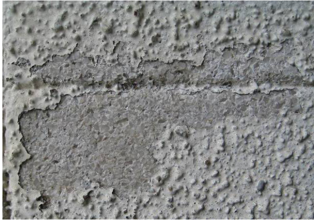
Vaskolitputs under senare påförd puts och färg
