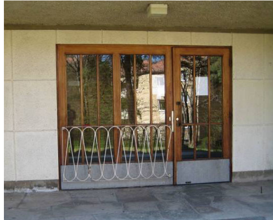
Ursprunglig entréport med smidesgaller
