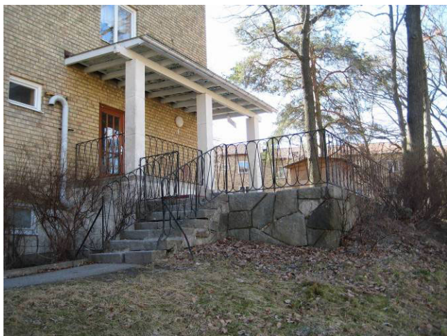
Terrass och trappa Blommensbergsvägen
